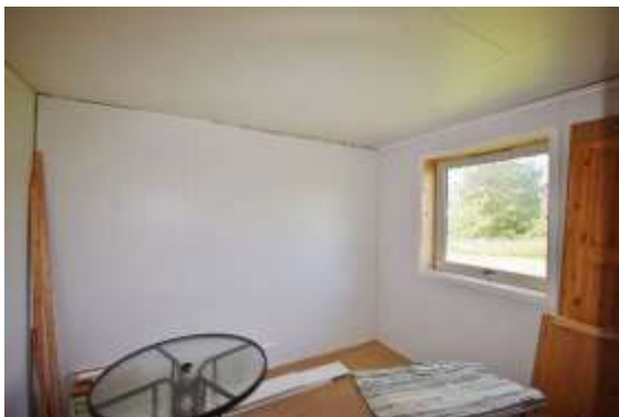
Soverom i underetg. - her gjenstår litt arbeid.
