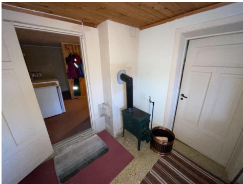
Vedaomn og sotluke på vaskerommet.
