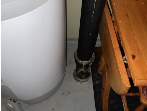
Soilstamme med stakeluke i kjellarbod.
